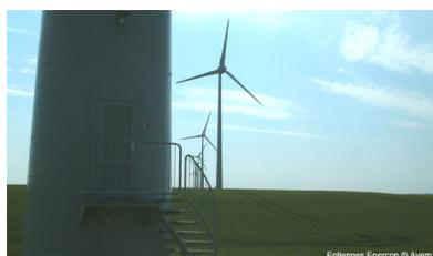
Pour faire court et simple, la grande différence entre une éolienne d'une marque concurrente comme [Vestas](#) ou [Gamessa](#), c'est que sur une machine [Enercon](#) on parle de générateur annulaire. Pas de grosse boîte de vitesses, donc pas de pertes mécaniques entre le rotor et la génératrice. Ce qui a permis
